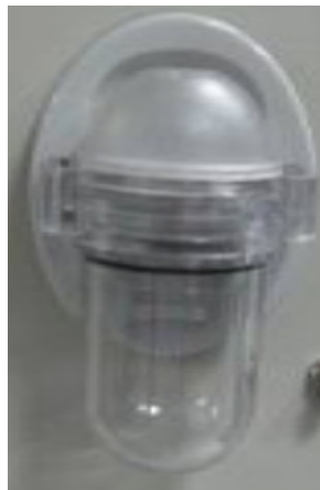
Figure 17--2 Colector de agua para el módulo de CO 2 KM7002
